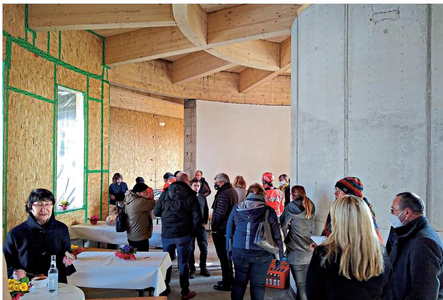
*Eine Rundbauaufstockung in Holzleichtbauweise*
